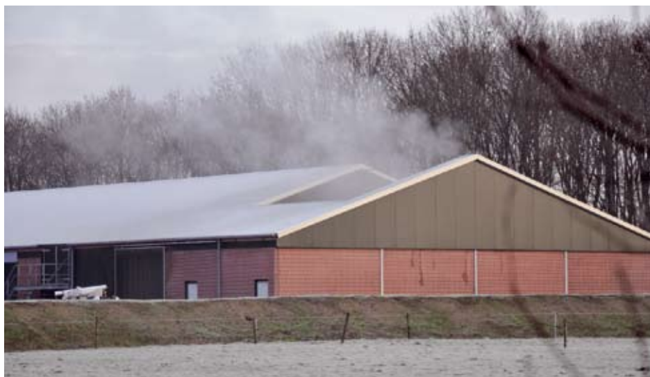
Filtro umidità antipolvere + depurazione biologica dell'aria + Essiccatore Dorset Pollo, per 60.000 galline
