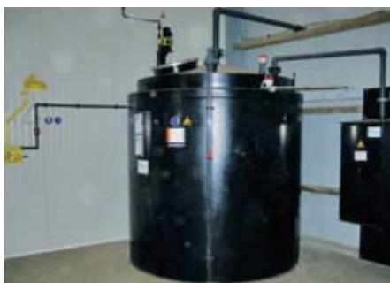
**Bei chemischen** Abluftwäschern oder Combiwäschern wird meist Schwefelsäure zur Ansäuerung des Waschwassers eingesetzt. Diese kann in festen Vorrattanks oder austauschbaren 1 m<sup>3</sup> Containern gelagert werden. Unten Lagerung des Abschlammwassers.
