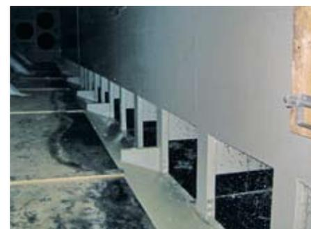
Als platzsparende Variante ist der Einbau des Abluftwäschers in Containerbauweise auch im Dachfirst möglich, über dem Kontrollgang des Schweinestalls. In diesem Fall ist der Waschwasservorratsbehälter entweder in der unteren Ebene oder auch wie der Abluftwäscher in der ersten Etage untergebracht. Hierbei sollte wegen des Wassergewichts auf die Tragfähigkeit der Stahlkonstruktion geachtet werden.
