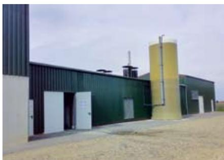
**Bei der Bindung von Ammoniak** mit schwefelsäurehaltigem Waschwasser entsteht Ammoniumsulfat, was z.B. in Polyesterbehältern gelagert werden.
