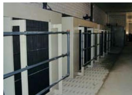
**Biologische Abluftreinigungsanlagen** für die Legehennenhaltung werden bei zusätzlichen Staubwäscher geliefert. Mit einer Kapazität von 2m<sup>3</sup>/h je Legehenne kann die biologische Abluftreinigung 70 % des jährlichen Abluftvolumens reinigen.
