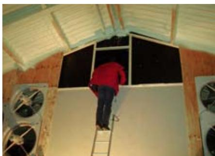
**Dorset baut seit 1994** Abluftwäscher für die Schweinehaltung. Diese können mit und ohne Zentralabsaugung geliefert werden. Der Dorset Biowäscher kann im Stall direkt auf Maß angepasst werden. Hierbei kann der Aufbau sowohl in der Mitte (kleiner Luftkanal), als auch seitlich oder am Ende des Stalles erfolgen.
