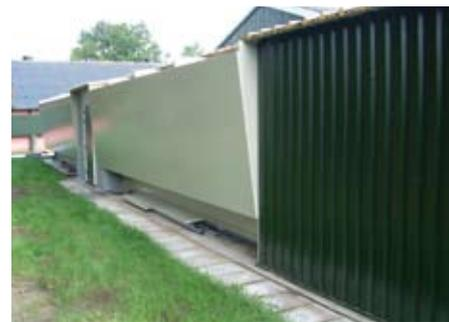
**Kombiwäscher für die Geflügelhaltung** werden derzeit durch ASG Wageningen einem ausführlichen Test unterzogen. Vorläufige Ergebnisse: ca. 70 - 90 % Ammoniakreduzierung und 50 - 70 % Geruchsreduzierung.
