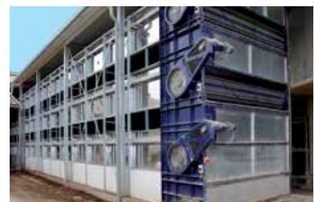
**Помет** ежедневно удаляется с фермы и сушится при помощи сушильной установки на протяжении двух дней. Это уменьшает образование аммиака и повышает содержание азота в конечном продукте. В результате в воздухе содержится меньше аммиака, а качество конечного продукта повышается.
