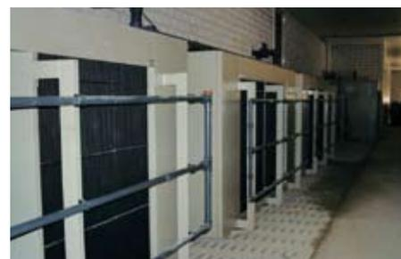
**Il depuratore biologico dell'aria** da installare negli allevamenti di galline ovaiole e' equipaggiato di un filtro extra per la riduzione delle polveri. Tale depuratore può pulire il 70% del totale annuale prodotto, con una capacita' di 2m<sup>3</sup>/h per gallina ovaiole.
