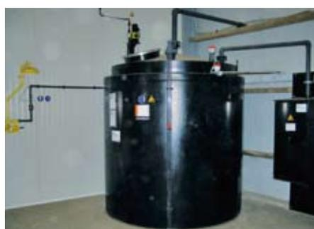
**Per un depuratore chimico o a tre fasi** si necessita dell'uso di acido solforico. Questo acido può essere depositato in una vasca rigida (vedi immagine) o in containers da 1000 litri circa.
