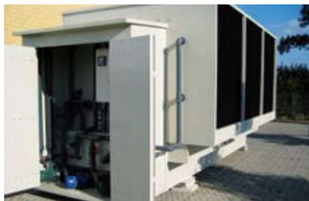
**Il depuratore Combi** pulisce l'aria fuoriuscente dagli impianti di essiccazione. Il sistema di depurazione Dorset a tre fasi e' stato progettato appositamente per l'aria ricca di ammoniaca e polveri in uscita da tali impianti che prevedono di trattare biomasse fermentate.
