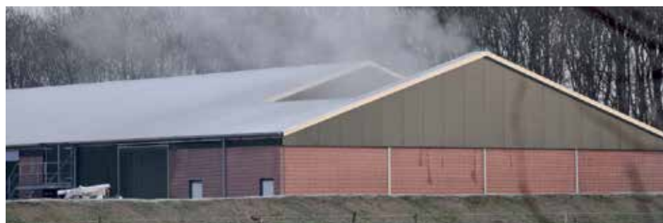
Filtro a polvo húmedo + lavador de aire biológico + secadero de gallinaza "Pollo" de 60 000 gallinas ponedoras
